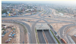
テマ立体交差点 (ガーナ国際回廊改善計画の一部) (ガーナ)
